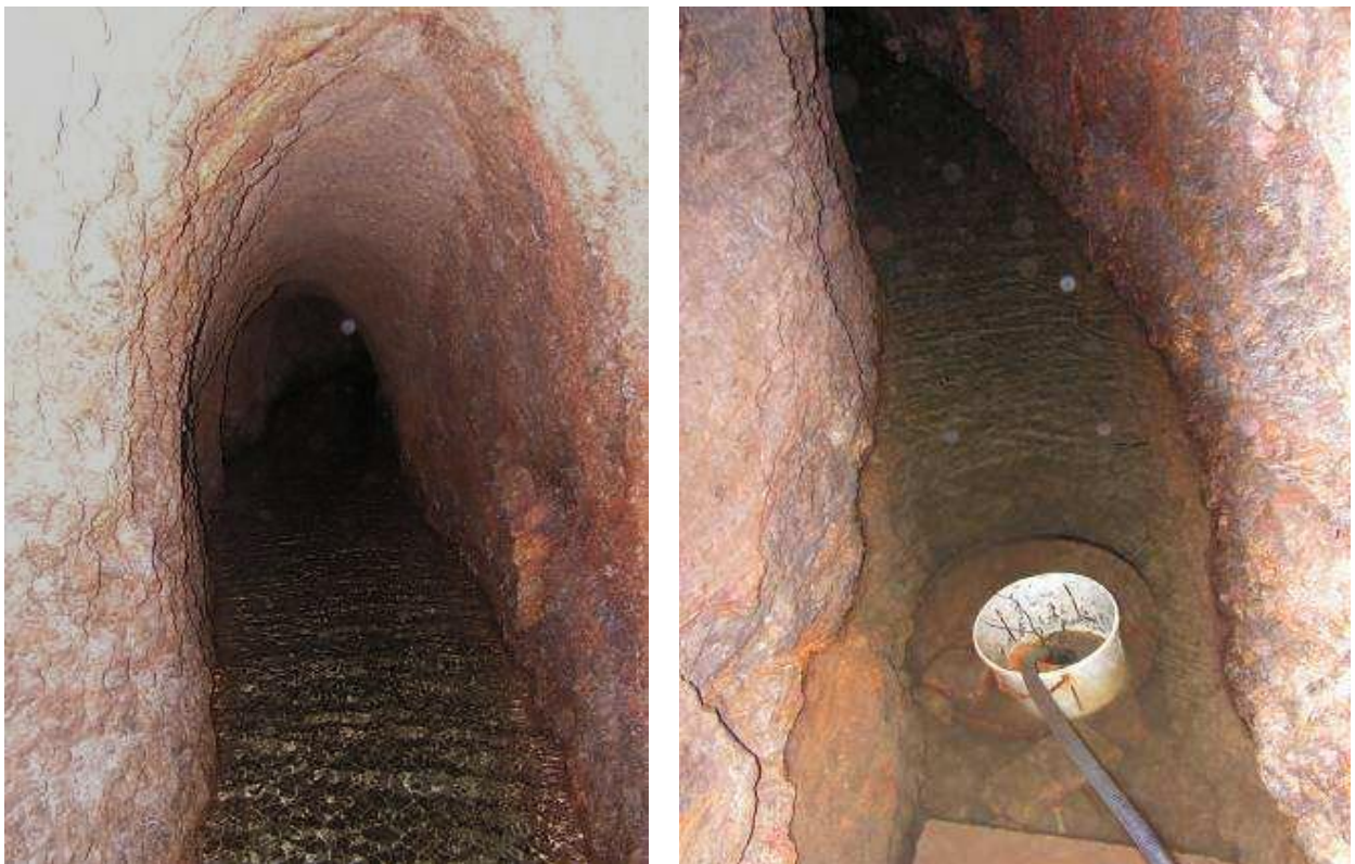
Obr. 42. Dolní Paseky č. 1 (2009). Vlevo: Profil štolou. Vpravo: způsob jímání vody ze štolý. Foto B. Karban, úplná dokumentace viz příloha.
