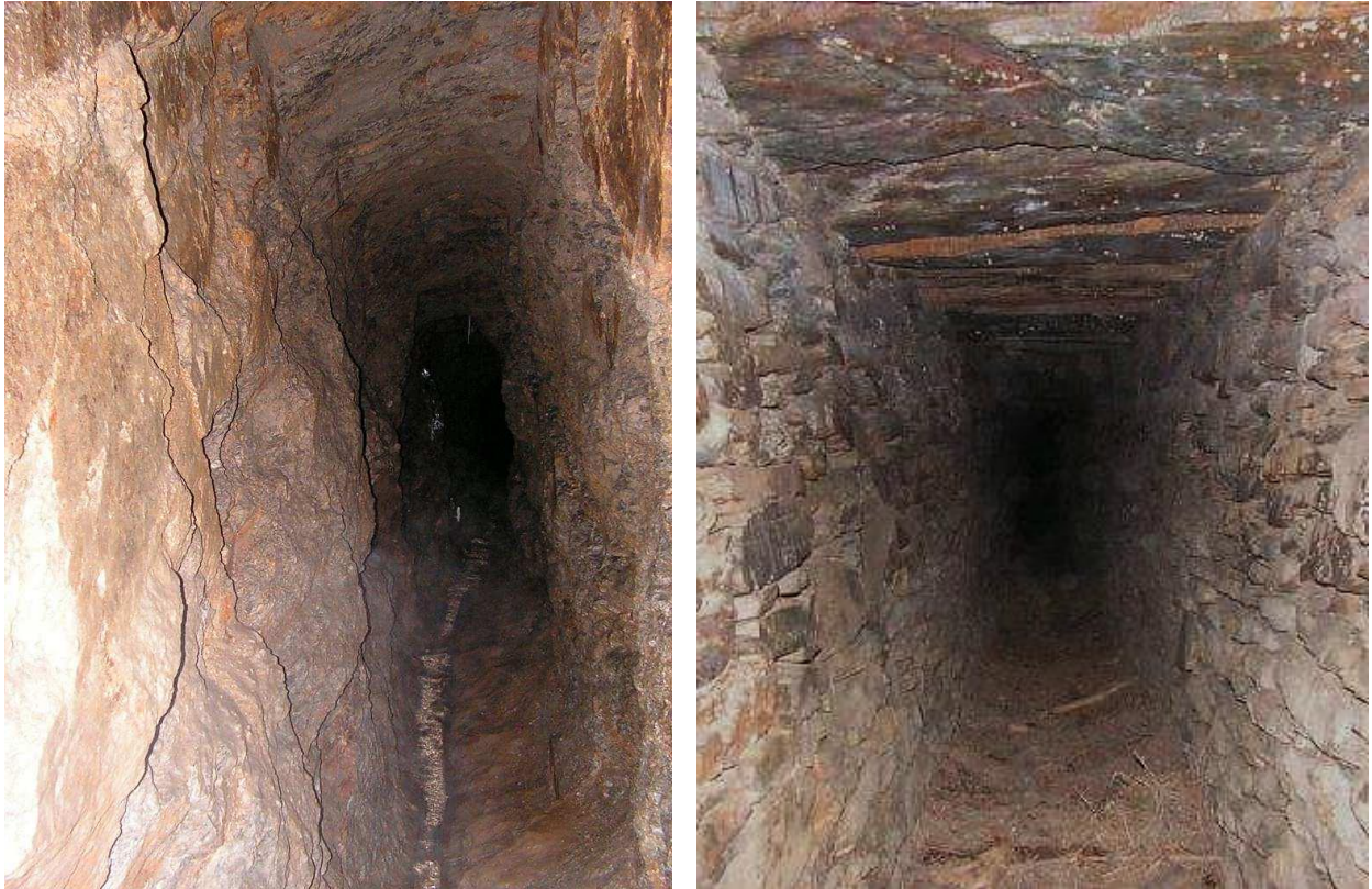
Obr. 41. Vlevo: Profil východní štolou Aš-Skřivánčí vrch (2012). Vpravo: Úvodní část štolý Podhradí s kamennou vyzdívkou (2009). Foto B. Karban, úplná dokumentace viz příloha.
