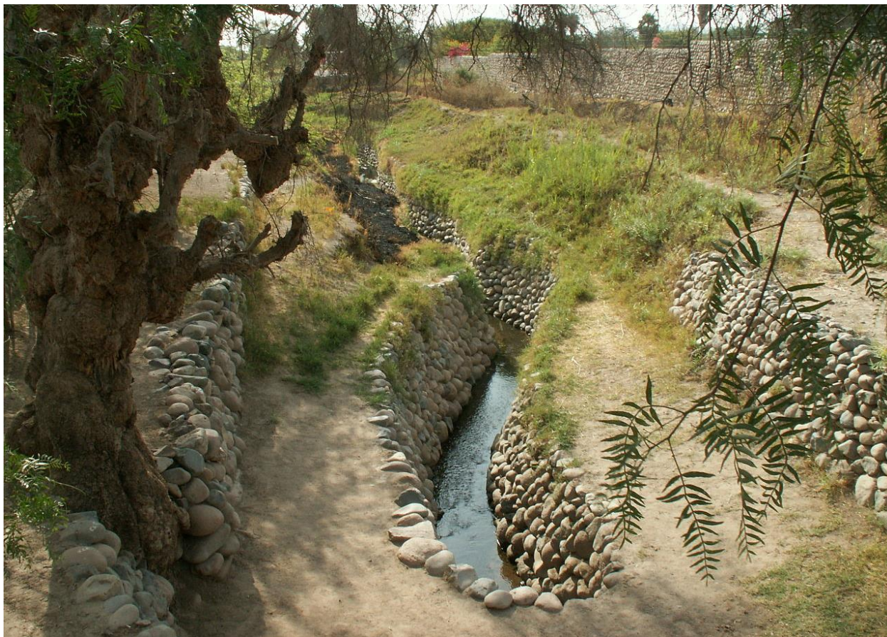
Obr. 27. Cantaloc, Peru. Vyústění vodní štoly do zavlažovacího kanálu (Foto Davide Mauro, https://en.wikipedia.org/wiki/Puquios ).
