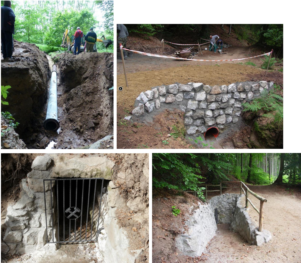
Obr. 45. Rekonstrukce ústí štoly Bílá paní 2015-2016 ( www.solles.cz ).
