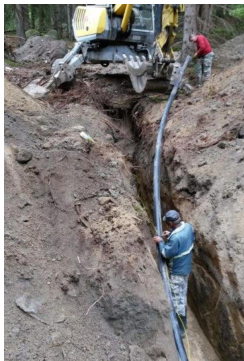
Obr. 6. Vlevo: Příčný řez jímacím zářezem. Vpravo: Stavba jímacího zářezu ( www.pospisil-ro.cz ).
