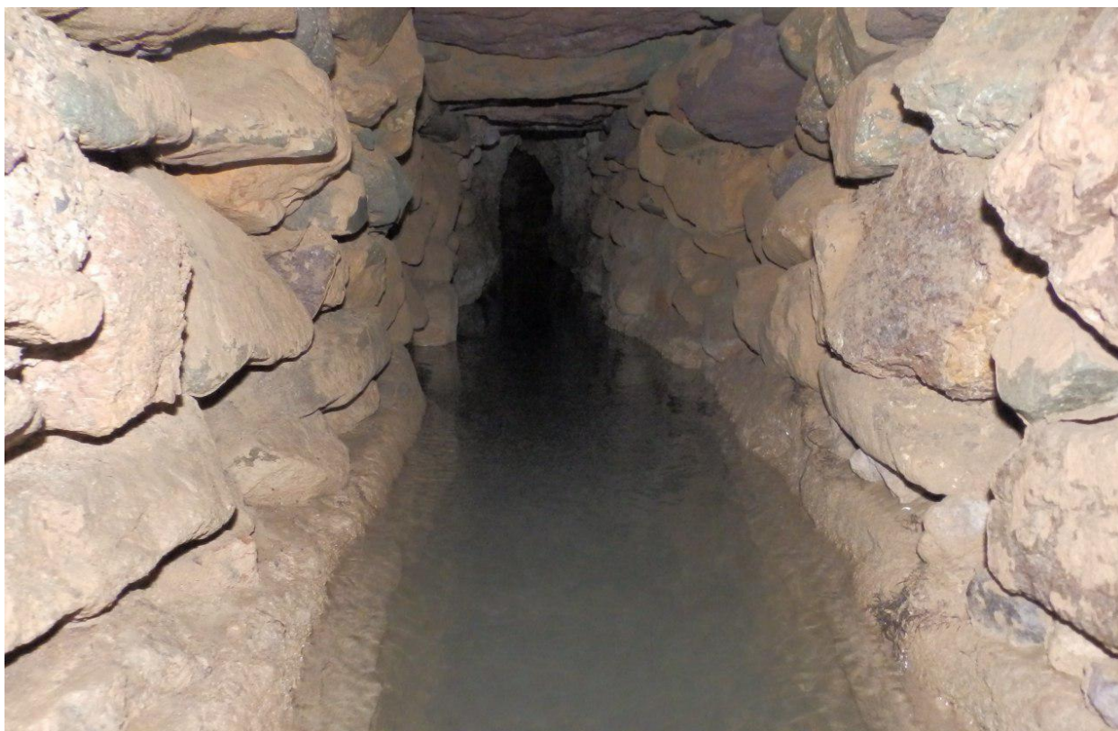
Obr. 14. Kamenná obezdívka kanátu Zibad v Gonabadu ( https://en.wikipedia.org/wiki/Gonabad ).
